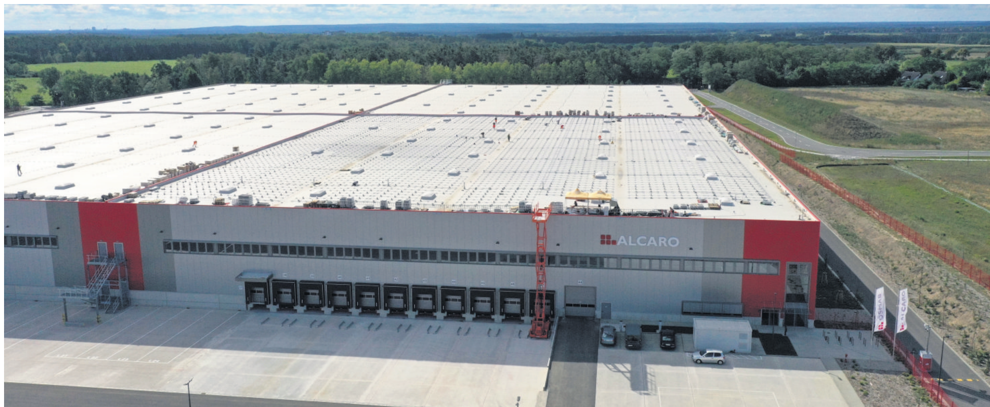
Die erste Halle von Alcaro im neuen Gewerbegebiet von Frankfurt (Oder) ist fast fertig. Quelle: Alcaro
